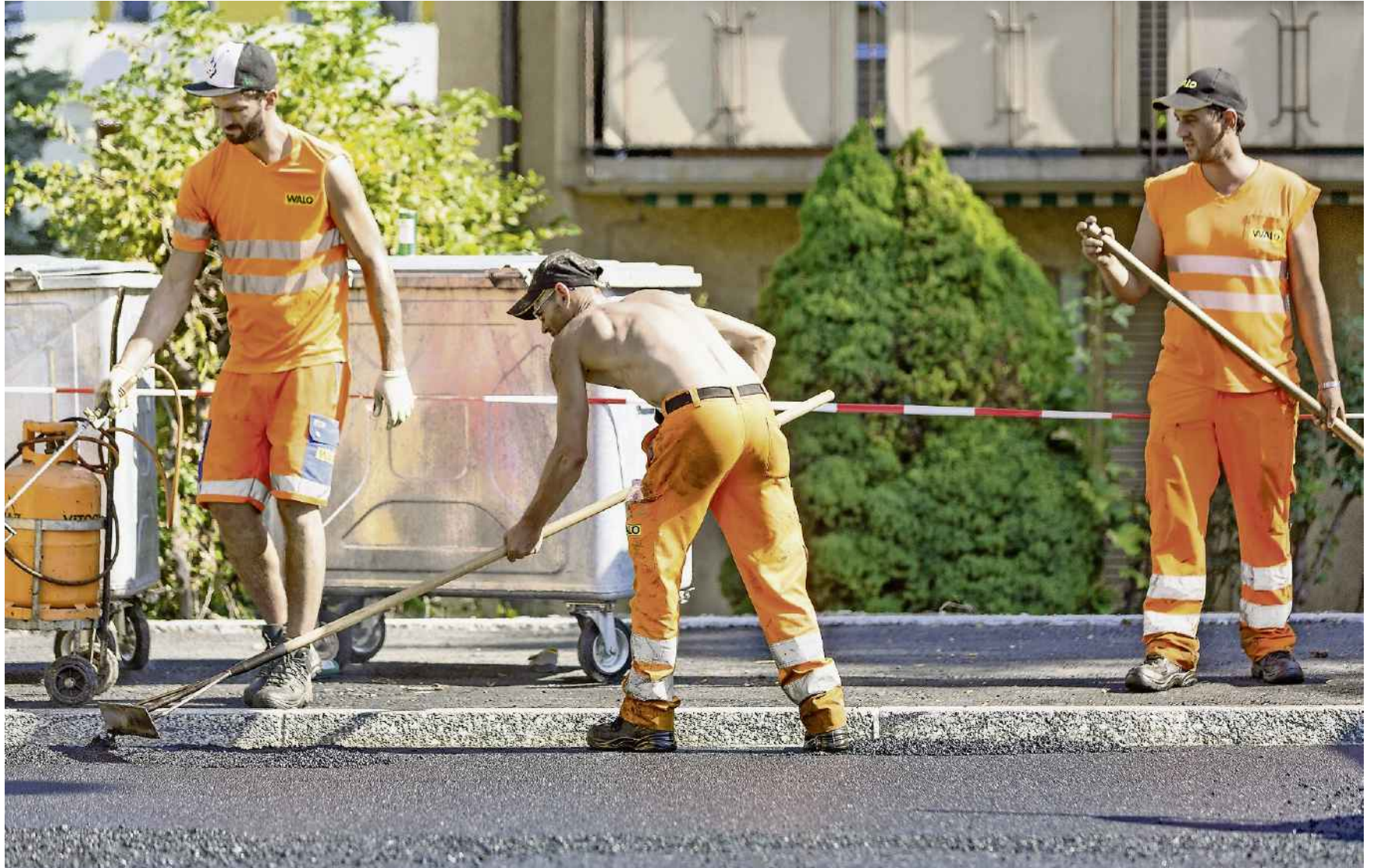
In brütender Hitze wurde letztes Jahr die neue Schönenwerdkreuzung gebaut. Ein Teil der Mühe ist nun für die Katz: Der Belag wird wieder aufgerissen. ARCHIV/C. ISELI
